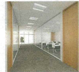
活動室と廊下の壁は木製 方立てガラススクリーン 【図2】「光の庭」周囲の廊下
